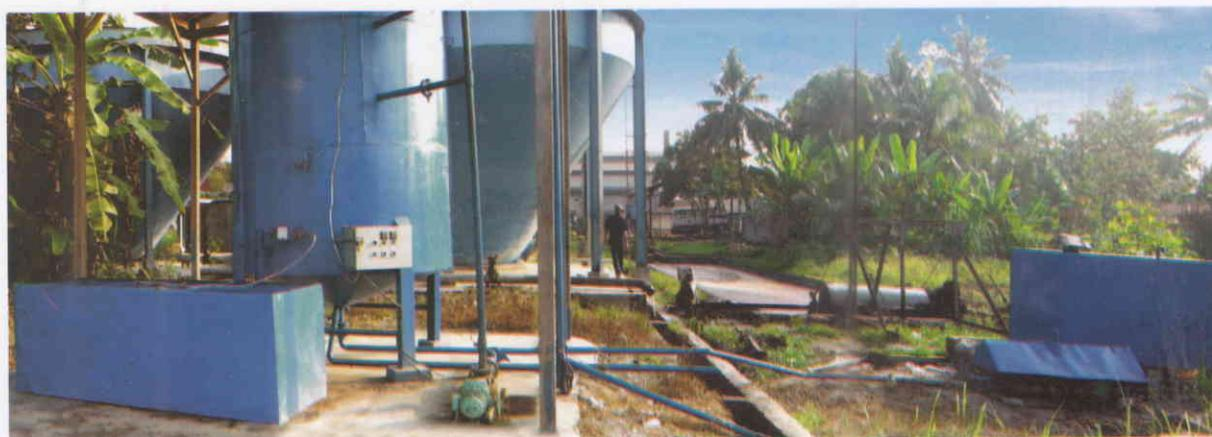
Gambar 2. Instalasi reaktor anaerobik tertutup.
