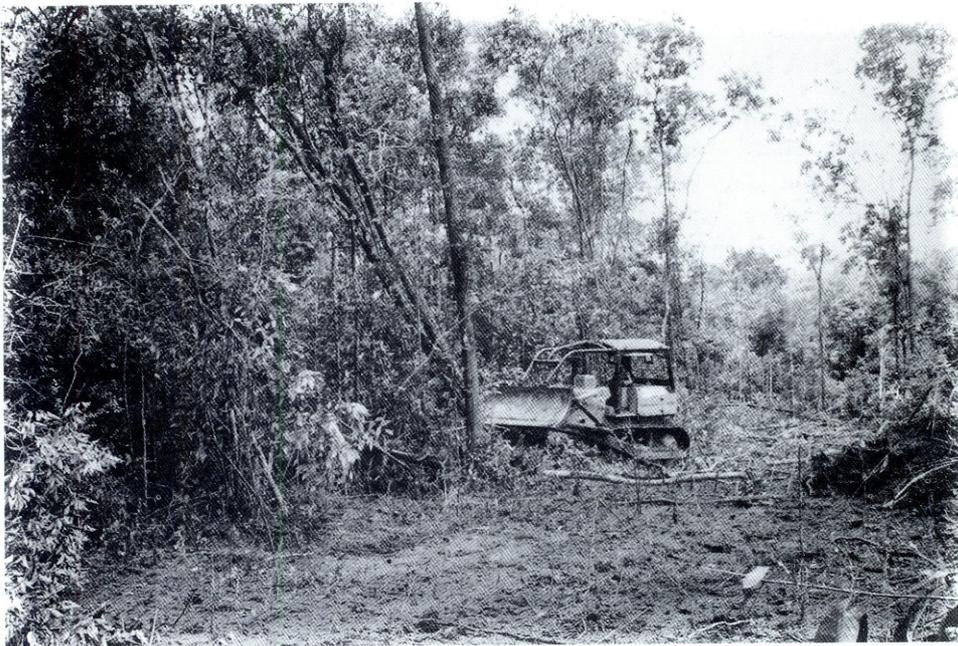
Gambar 1. Penumbangan pohon dengan *buldozer*
